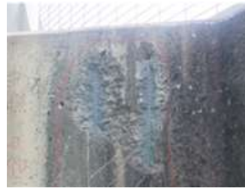
注) 露出した鉄筋は、防錆のために一時的に塗装してある。
