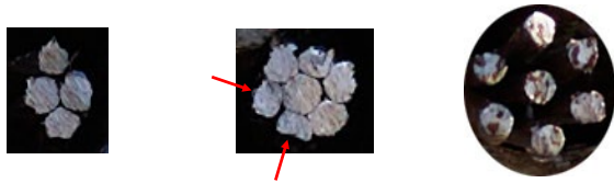
(a) 素線減少 (b) 素線の断面減少 (c) よりが戻っている
