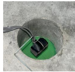
写真一3 測定装置
