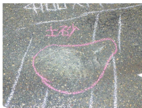
図-2 土砂噴出の事例
