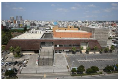
写真-1 建築物外観
