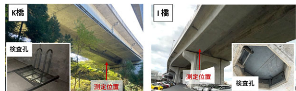
写真-1 対象橋梁外観 (左: K 橋, 右: I 橋)
