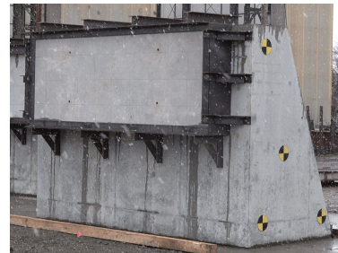
(b) 試験体の設置状況
