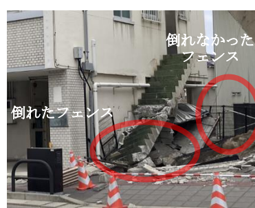
写真-2 隣地状況
