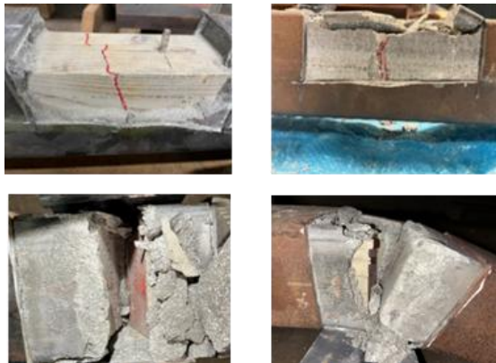
写真-7 局部座屈部の内部詳細（角形）
