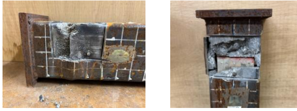
写真-2 角形短柱の内部の様子
