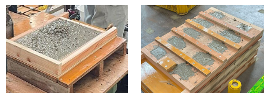
写真-1 外殻 PCa 板製作状況
