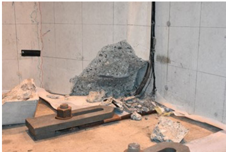
写真-2 供試体 (Lo-R) 下部の側壁ハンチ損傷状況
