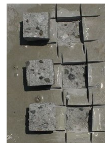
写真-4 付着試験破壊断面
