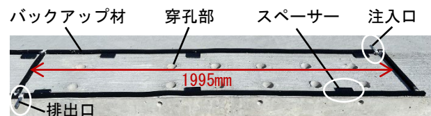
写真-1 壁高欄との接合面（床版側）
