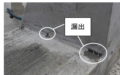
写真-2 エポキシモルタル充填時の漏出状況
