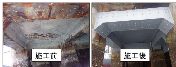
図-1 繊維補強埋設型枠工法の適用実績
