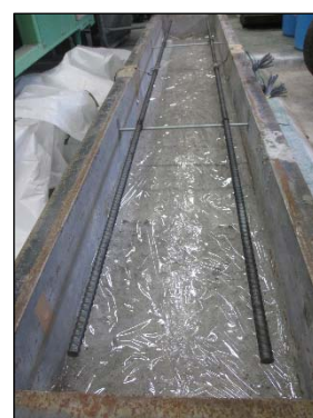
写真－2 フィルム敷設
