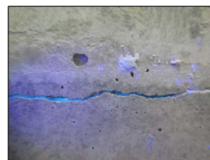
写真-6 充填状況
