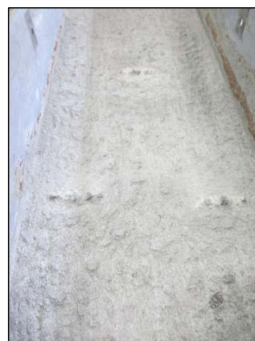
写真－1 粗骨材露出
