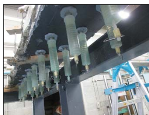
写真-5 注入状況
