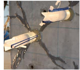
図-5 補修の様子
