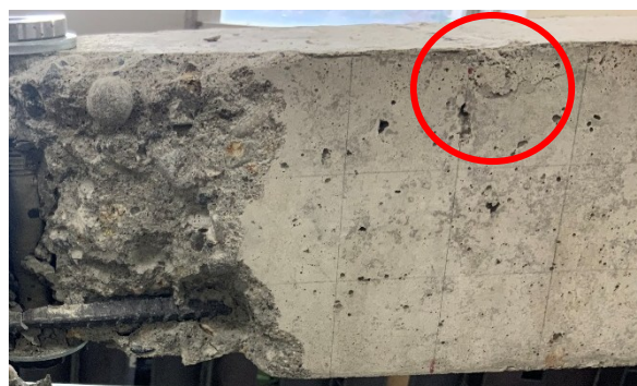
図-11 試験体2の曲げ試験終了後の載荷位置における局所的な損傷
