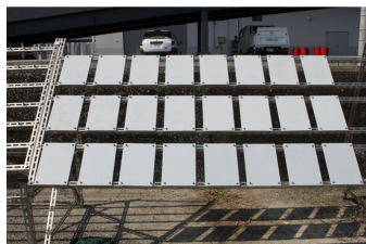
写真-1 暴露状況
