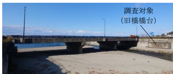
写真-3 橋梁全景 (B 橋)
