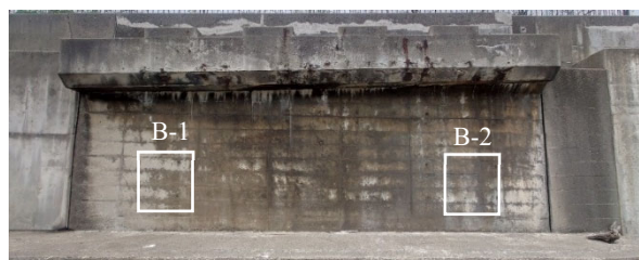
写真-4 調査箇所 (B 橋)
