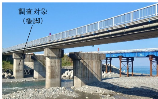
写真-1 橋梁全景 (A 橋)
