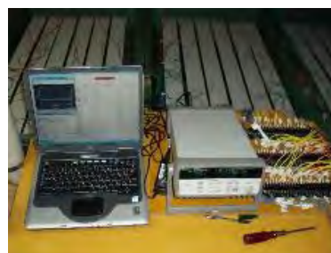
図－3 自然電位の連続計測状況
