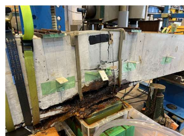
写真-5 電食範囲の外観（腐食率 30%）
