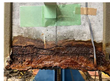
写真-4 電食範囲の外観（腐食率 20%）
