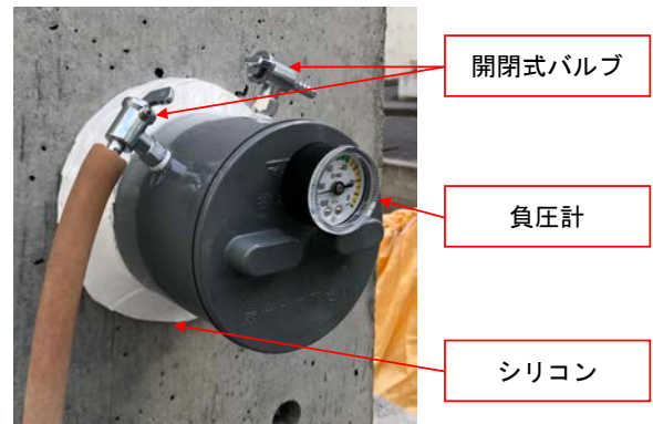
写真-2 簡易透気試験の測定風景
