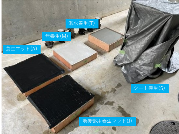
写真-1 養生の様子
