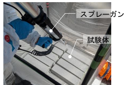
写真-1 吹付け法による防水層の施工状況
