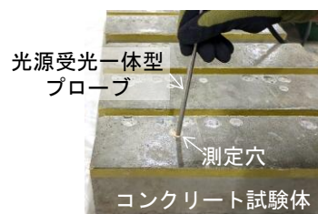
写真-3 近赤外分光法での測定状況
