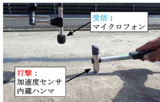
写真-3 打音法による測定状況の例
