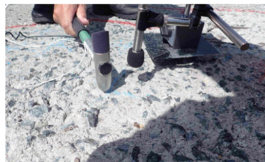
写真-4 C橋の床版上面
