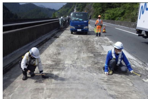
写真-1 舗装打換工事に伴う RC 床版表層の打音検査
