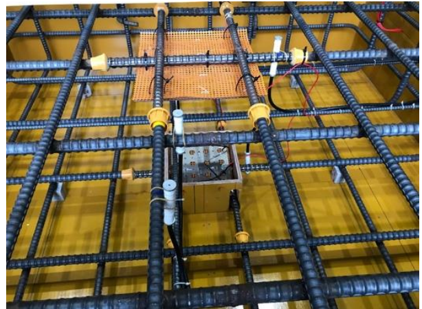
図－４ 試験体中央部の電極と配筋状況
