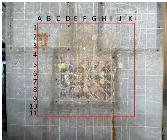
図-6 試験体の打音検査状況
