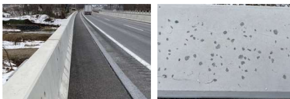
A) 高欄設置状況
