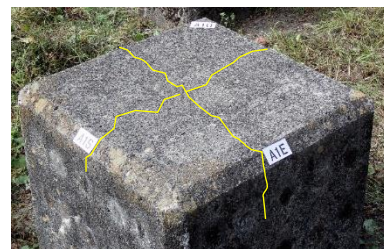
写真-4 大型供試体上面に生じたひび割れ
