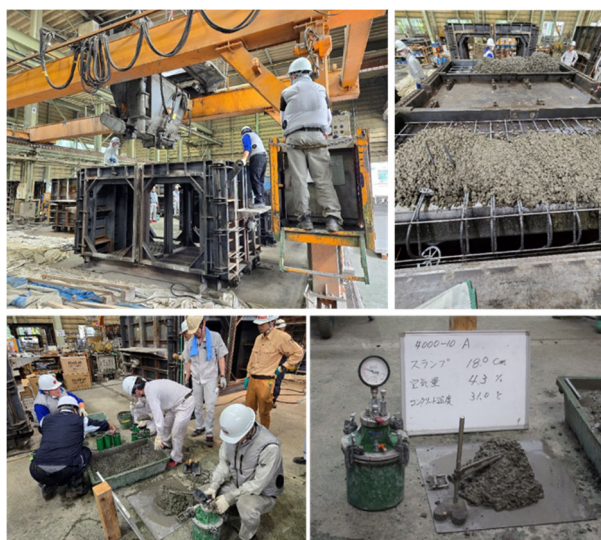
写真-1 L型擁壁への打込み・試験状況の例
