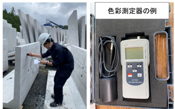
写真-2 L型擁壁の曝露状況および色彩測定の様子
