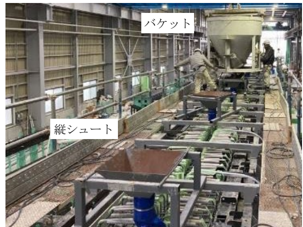
写真-1 バケットによる打込みの例
