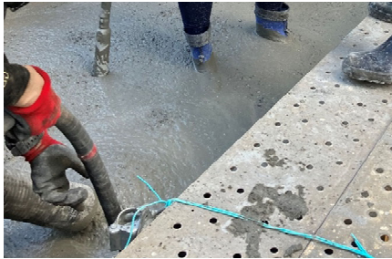
写真-1 実施工での締固め状況
