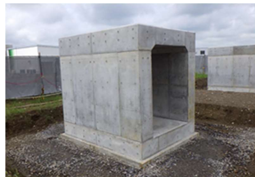
写真-5 完成したボックスカルバート（BFA 使用）
