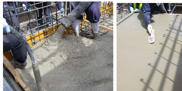
写真-4 コンクリートの打込みおよび仕上げの状況
