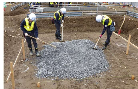
写真-3 基礎砕石の施工状況
