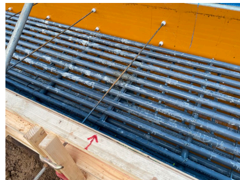
写真-1 塩ビ管の配置状況
