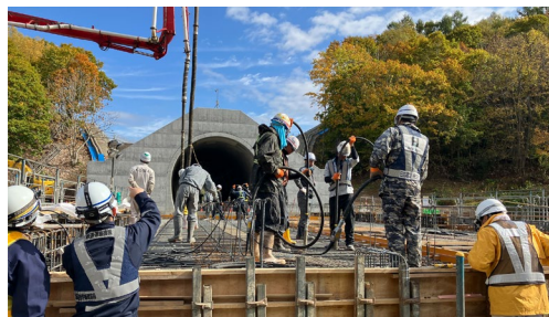
写真-4 実施工の状況
