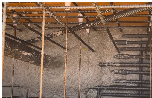
写真-5 コンクリートの打込み状況
