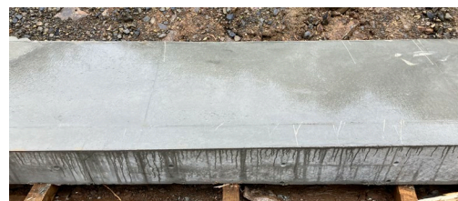
写真-3 反転させた試験体底面の状況
