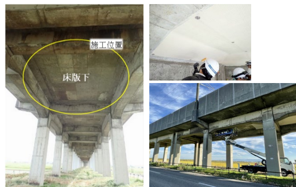
図－１３ 施工位置、及び施工風景
