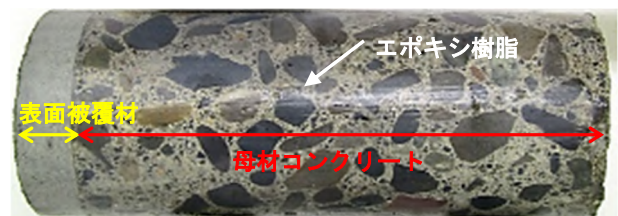
写真-2 コアのシール状況 (例: H-1)
