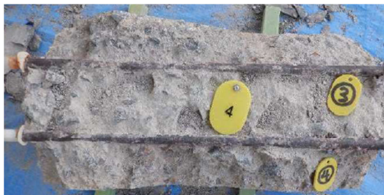
鉄筋 3・4 (錆び落とし無し), 表面側, グレード 2
