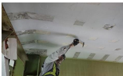
写真-2 打音検査状況
