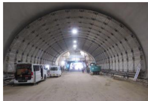
写真-1 既存の養生システム例(給水養生型)
