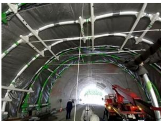
写真-7 トンネル実験施設での載荷実験の状況
