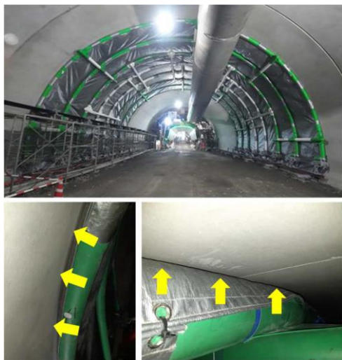
写真-8 小径バルーンの覆工面への密着状況
