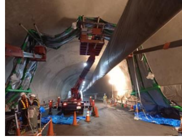
写真-10 小径バルーン養生システム設置作業の状況
