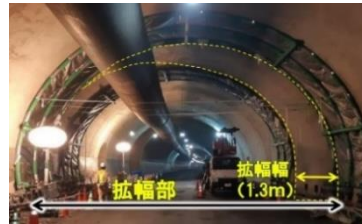
写真-11 トンネル断面変化部での設置状況
