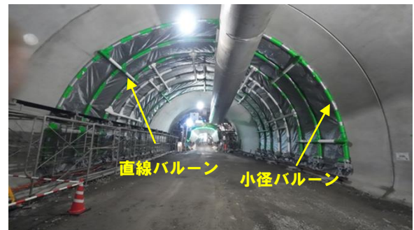
写真-3 小径バルーンを用いた養生システム
