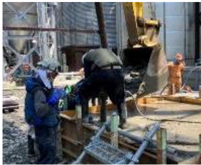
写真-5 コンクリートの打込み状況
