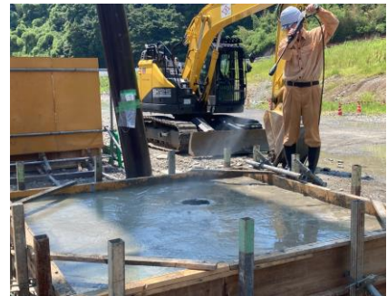
写真-6 新規打継目処理剤の散布状況
