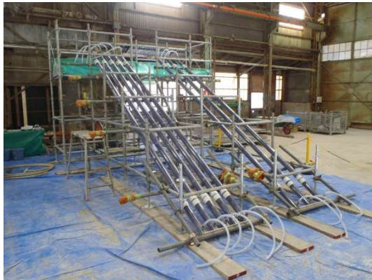
写真－１ 先流れ試験 試験体設置状況
