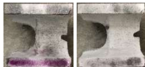
擁壁ブロック
