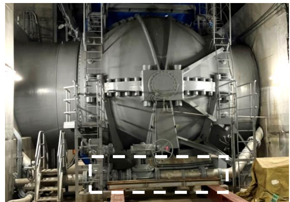
写真-1 既設コンクリート構造物（鉄管弁架台）
