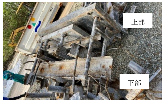
写真-2 構造物中の鋼材
