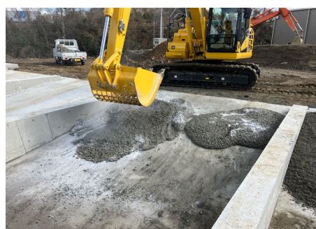
写真ー2 粒状化再生粗骨材製造状況
