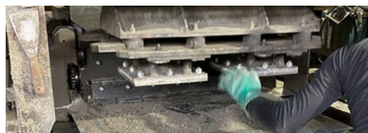
写真-6 型枠への材料投入および締固め状況
