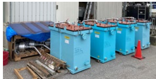
写真-2 炭酸化作業 (配管の接続状況)
