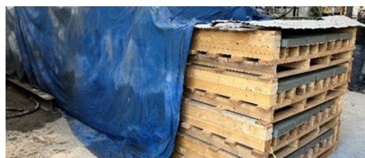
写真-8 蒸気養生状況
