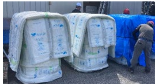
写真-3 炭酸化作業 (炭酸化槽及び配管の保温)
