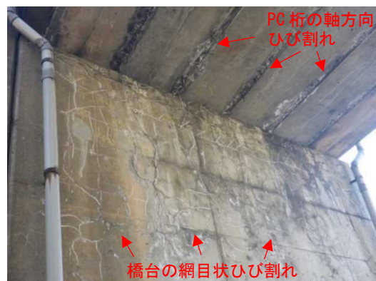
写真-1 プレテン PC ホロー桁および橋台に発生したひび割れ
