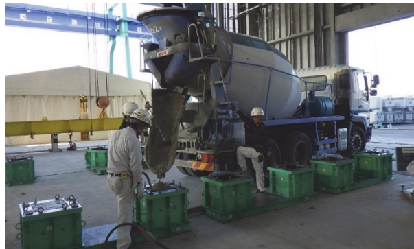
写真-4 プレキャスト工場での打設状況
