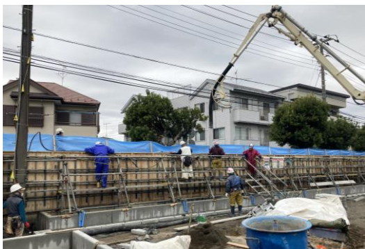
写真-2 打込み状況
