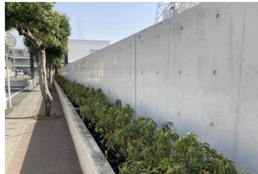
写真-3 壁状部材の外観
