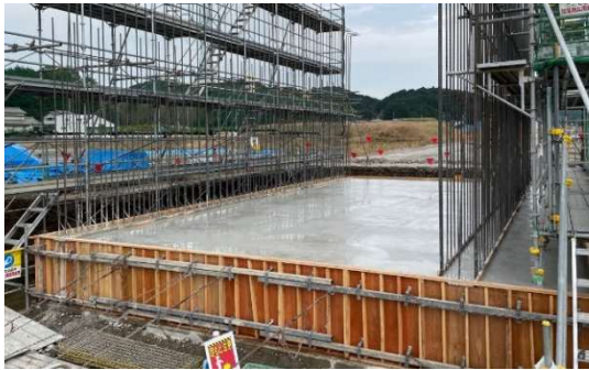
図-11 打設後の状況
