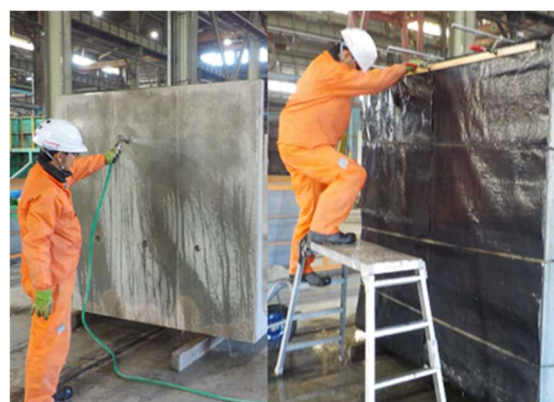
(a) 散水状況 (b) シート敷設状況
