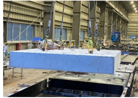
図-13 加熱養生直後の吊上げ状況
