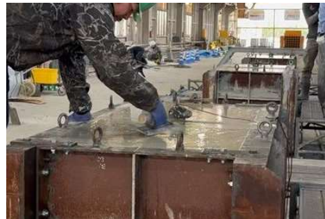
写真-1 大型ブロックの仕上げ状況
