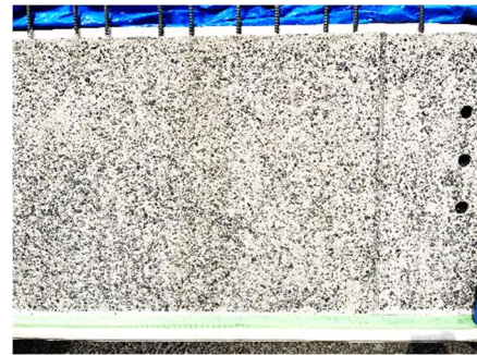
写真-4 粗骨材の分布状況
