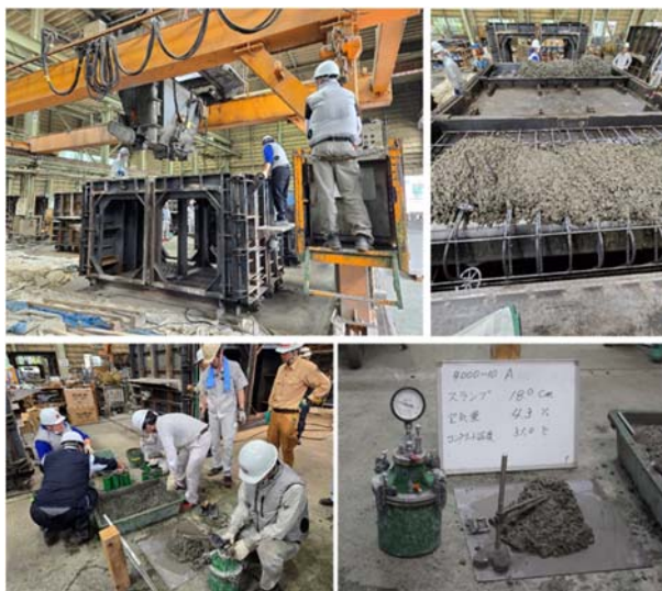
写真-1 各種試験とL型擁壁型枠への打込みの状況
